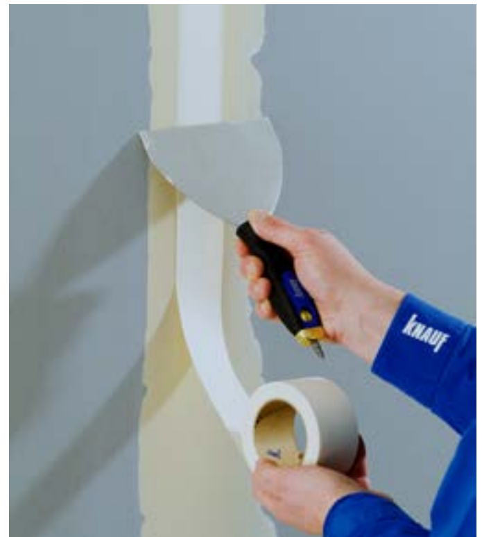
Bild 66 Knauf Uniflott FINISH Verarbeitungsfertige, rein weiße Spachtelmasse für Hand- und Maschinenverarbeitung. Zum vollflächigen Überspachteln für Qualitätsstufen Q3 und Q4. Keine Grundierung nötig! 8 kg Eimer
