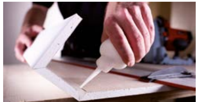
Bild 6 Knauf Platte falten und kleben (Foto: © Mafell AG)
