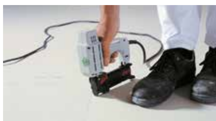
mit Knauf Brio-Schrauben oder mit Klammern im Abstand \leq 30 cm fixiert
