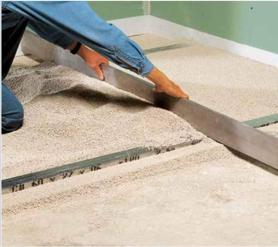
Knauf Trockenschüttung PA wird mit der Abziehle eingebaut. Nach Ausrichten der Auflageleisten wird die Schüttung abgezogen. Bei Schichtdicken von 50 bis 100 mm Knauf Trockenschüttung PA zusätzlich verdichten
