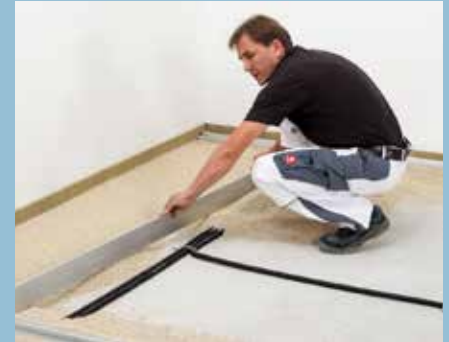
Knauf Trockenschüttung PA wird mit der Abziehle eingebaut. Nach Ausrichten der Auflageleisten wird die Schüttung abgezogen. Bei Schichtdicken von 50 bis 100 mm Knauf Trockenschüttung PA zusätzlich verdichten
