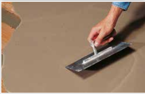
Unebene Holzuntergründe können mit Knauf N 320 Flex gespachtelt werden.
