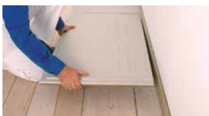
Am Wandanschluss werden die Elemente mit abgeschnittenem Stufenfalz verlegt
