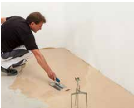
Die fließfähige Spachtel wird mit Traufel oder Zahnrakel auf ein gleichmäßiges Niveau gezogen
