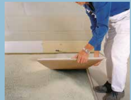
Die Verlegung der Brio-Elemente erfolgt bei Ausgleich mit Knauf Trockenschüttung PA, vom verlegten Boden aus, damit die Schüttung nicht betreten werden muss
