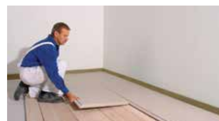
Die nächsten Brio-Elemente werden mit dem oben liegenden Falz in den Kleber eingelegt
