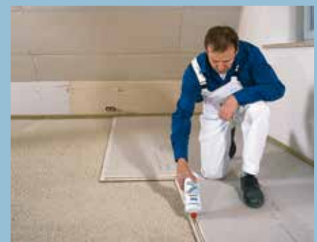
Auftragen von Knauf Brio Falzkleber in zwei Schnüren
