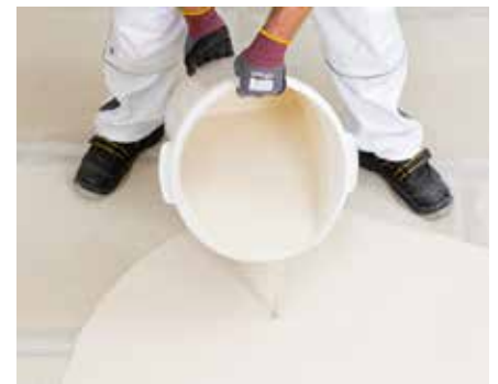
Knauf N 410 ist spannungsarm und ideal zum Spachteln von Fertigteilestrichen
