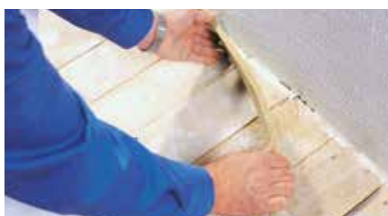
Randdämmstreifen werden an allen Wänden, Stützen etc. aufgestellt
