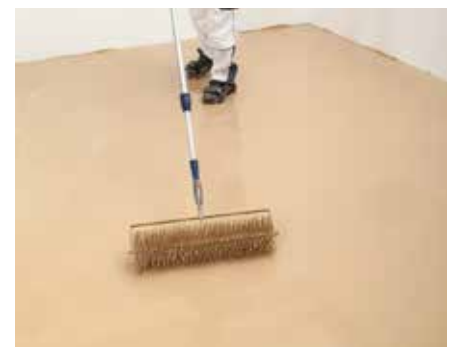
Mit der Stachelwalze wird eine besonders ebene Oberfläche erzielt
