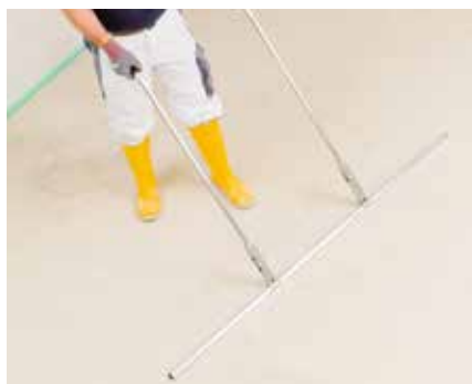
Die fließfähige Spachtel wird mit Traufel oder Zahnrakel auf ein gleichmäßiges Niveau gezogen
