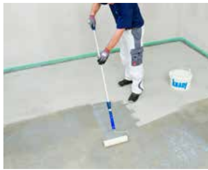
Die Oberfläche wird mit Knauf Estrichgrund (1:1 mit Wasser verdünnt) grundiert
