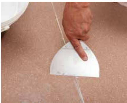
Plattenstöße mit Knauf Uniflott schließen
