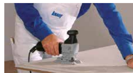
Knauf Brio lässt sich sowohl mit der Kreissäge als auch mit einer Stichsäge schneiden
