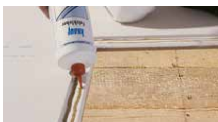
Knauf Brio Falzkleber wird in 2 Schnüren auf den unten liegenden Falz aufgetragen
