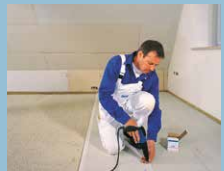
Der obere Falz wird durch das Körpergewicht auf den unteren gepresst und dabei verschraubt oder geklammert
