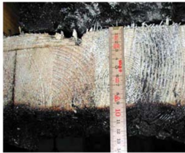
Abbildung 58: Restholzquerschnitt im Bereich der Fuge bei Falzbrettverbindung
