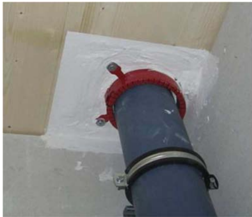
Abbildung 88: Befestigung einer Brandrohrmanschette im Weichschott nur mit durchgehender Befestigung zulässig, siehe rechtes Bild, Quelle: Firma Intumex
