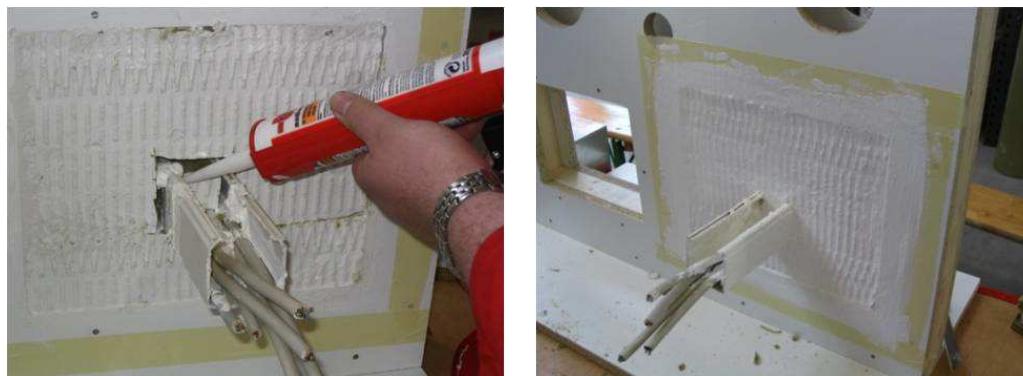
Abbildung 86: Abdichtung der Kabeldurchführung und fertige Abschottung, Quelle: Firma Würth
