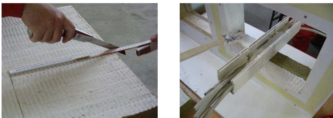
Abbildung 85: Zuschchnitt der Mineralfaserplatte und Beschichtung der Platten und der Leibung, Quelle: Firma Würth
