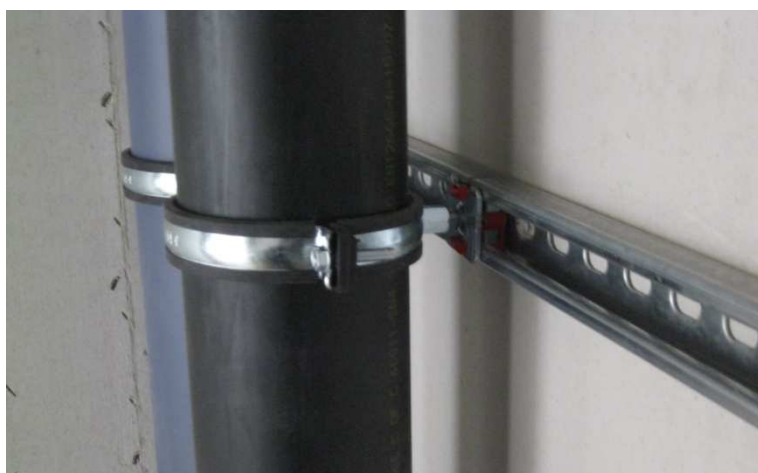
Abbildung 81: Schallschutztechnische Entkoppelung der Rohre
