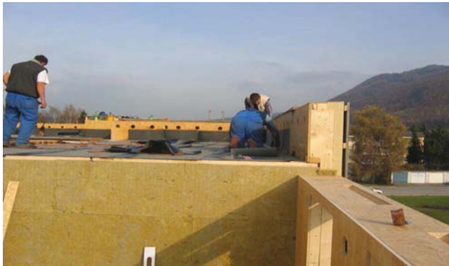
Abbildung 46: Dampfbremse (Bitumenabdichtung) am Flachdach als Bedarfswitterungsschutz
