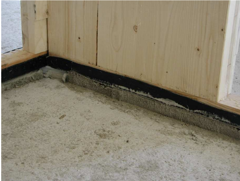
Abbildung 50: Auflagerdetail einer Innenwand
