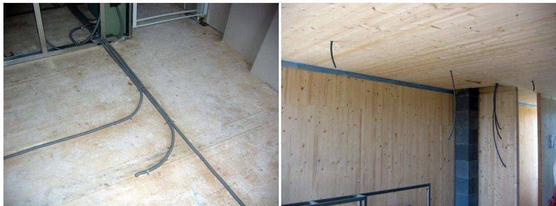
Abbildung 37: E-Leitungsführung bei sichtbarer Brettsperrholzdecke ist luftdicht auszuführen
