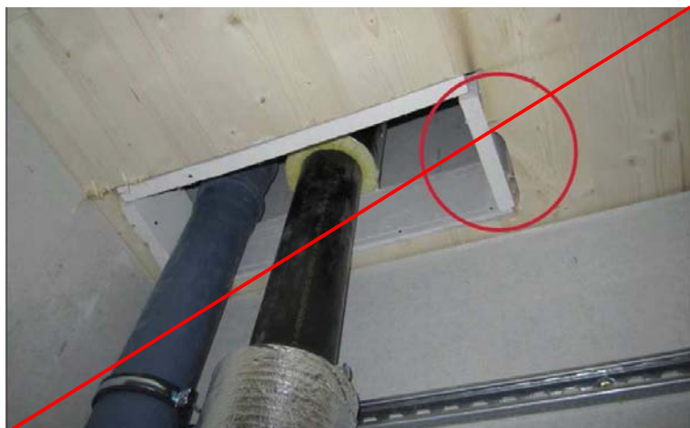
Abbildung 80: fehlerhafte Ausführung: Nicht vollflächiger Einbau der Leibungsverkleidung
