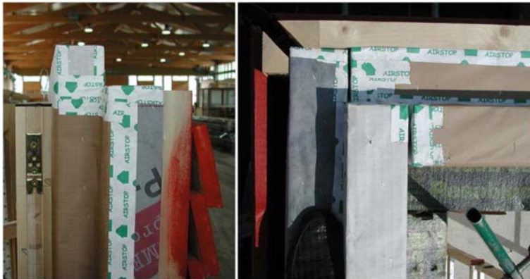
Abbildung 55: Außenwanddecke: links Vorfertigung (Ansicht); rechts Montage (Draufsicht)
