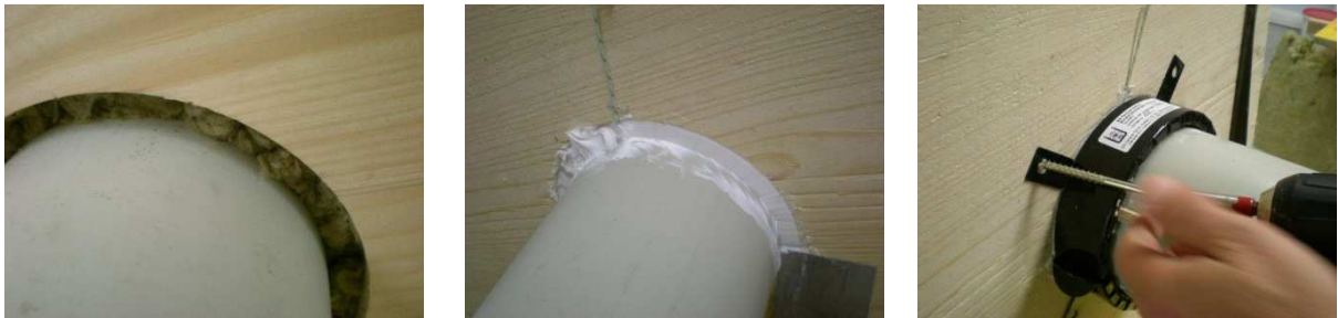
Abbildung 87: Einbau einer Brandrohrmanschette direkt in einer unbekleideten Massivholzwand; links: ausstopfen des Ringspaltes, Mitte: intumeszierende Brandschutzmasse, rechts: Befestigung der Brandrohrmanschette
